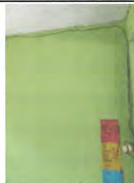
Foto 6: Reparación de repello y cernido en muro de mampostería con aplicación de acabado uniforme en área aulas y bodega.
