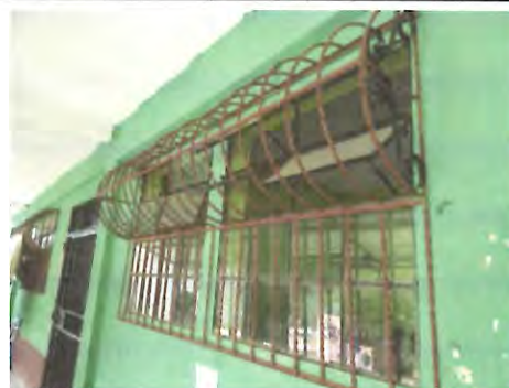
Foto 2: Sustitución de ventanas; sistema de apertura: Corredizas, Perfiles color blanco estandar, Material del marco: PVC Material de la ventana: Vidrio, sellado perimetral.
