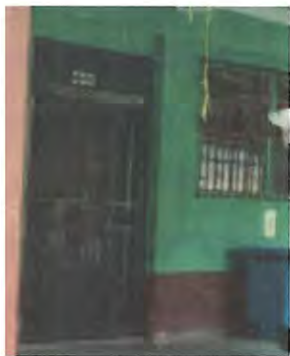
Foto 1: Mantenimiento a puerta metálica existente retiro de óxido, suciedad y pintura deteriorada; incluye cepillado, lijado y aplicación de pintura.
