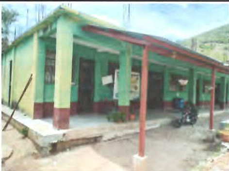
Foto 3: Preparación de la superficie y aplicación de pintura a dos manos, en paredes interiores y exteriores del establecimiento.
